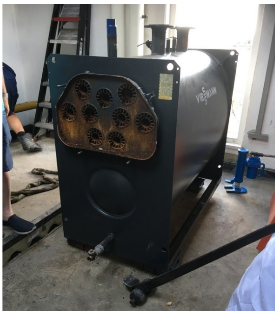
Foto 2: De oude installatie gedemonteerd.
