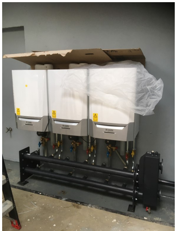
Foto 9: De nieuwe ketels gemonteerd.
