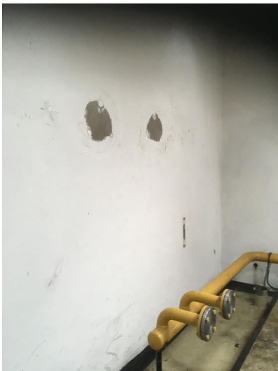
Foto 7: Oude gaten gedicht.
