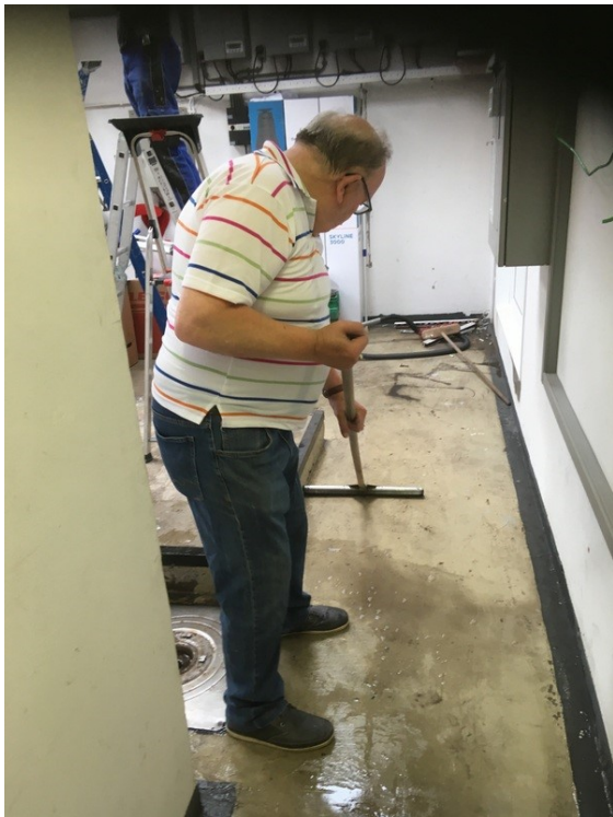
Foto 6: Er zit nogal wat water in zo'n installatie.
