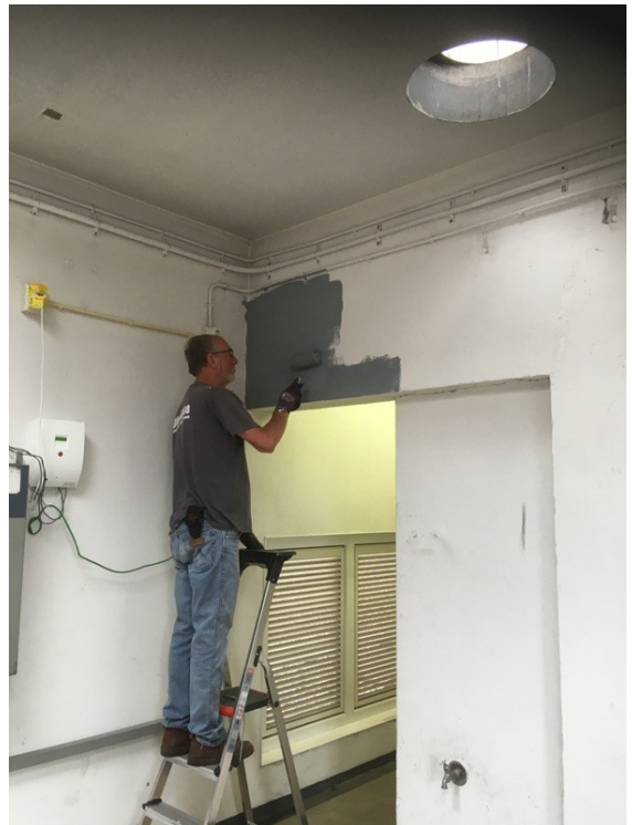
Foto 8: Een nieuw verfje erop!
